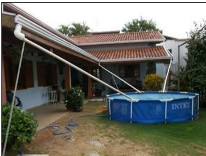
Figura 1: Solução inadequada de captação direta de água de chuva como complementação de abastecimento.
