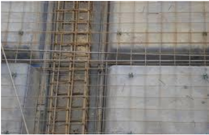
Figura 12: Armação de lajes nervurada moldada no local. Fonte:[9].
