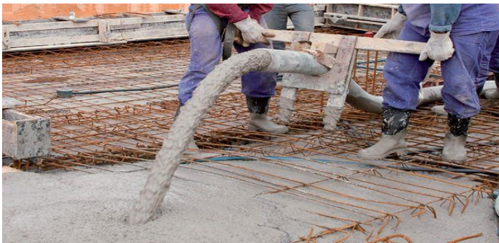
Figura 13: Concretagem das lajes nervuradas. Fonte: [9].
