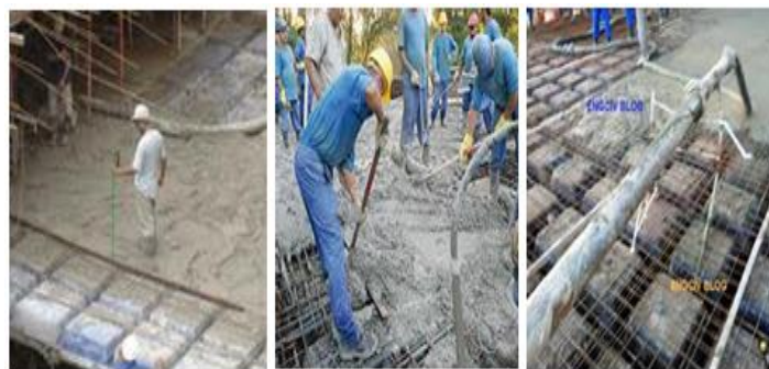
Figura 14: Concretagem das lajes nervuradas
