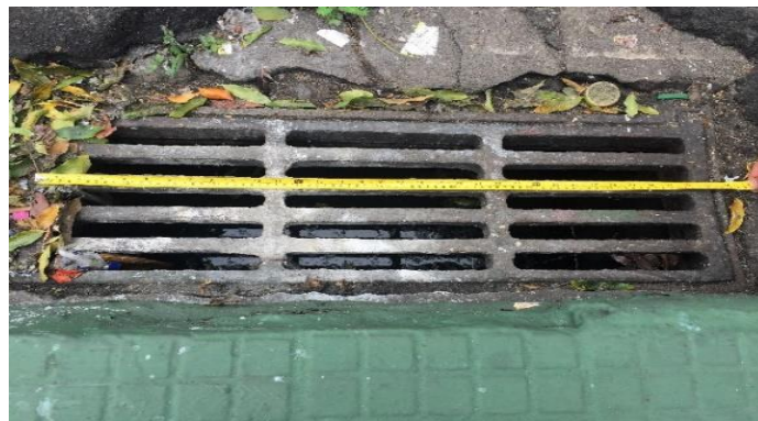
Figura 6: Boca de lobo I. Fonte: Autores, (2018).
