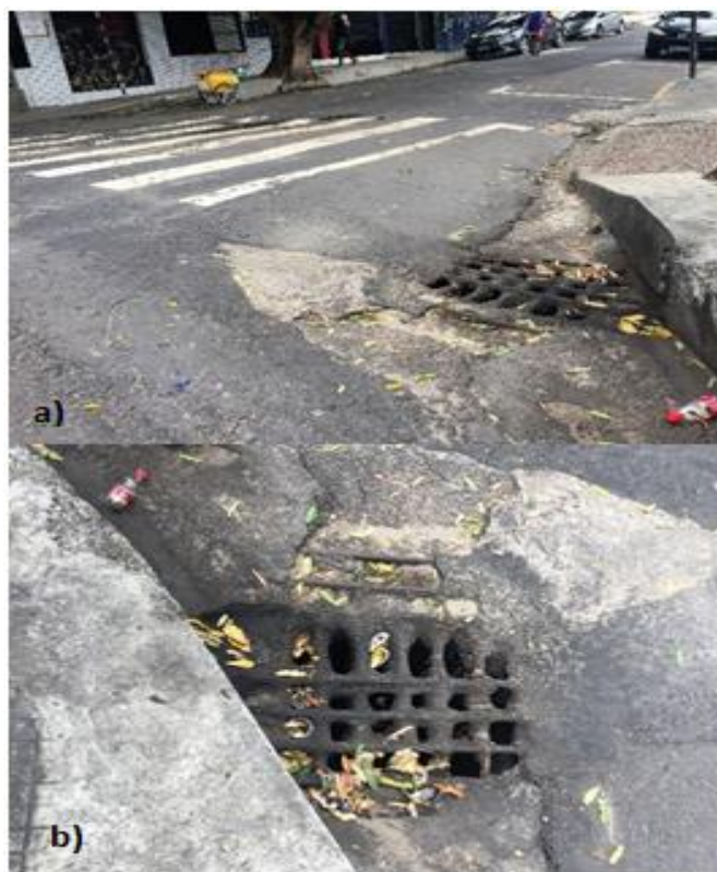
Figura 7. Boca de lobo II. Fonte: Autores, (2018).
