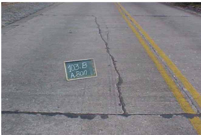
Figura 9: Fissuras longitudinais. Fonte: DNIT 061/2004.
