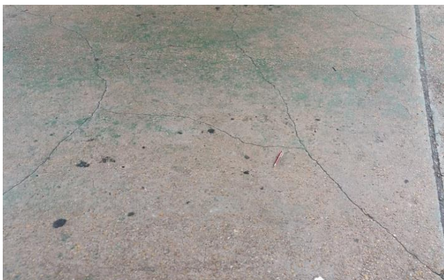
Figura 10: Fissuras diagonais. Fonte: Autores, (2018).
