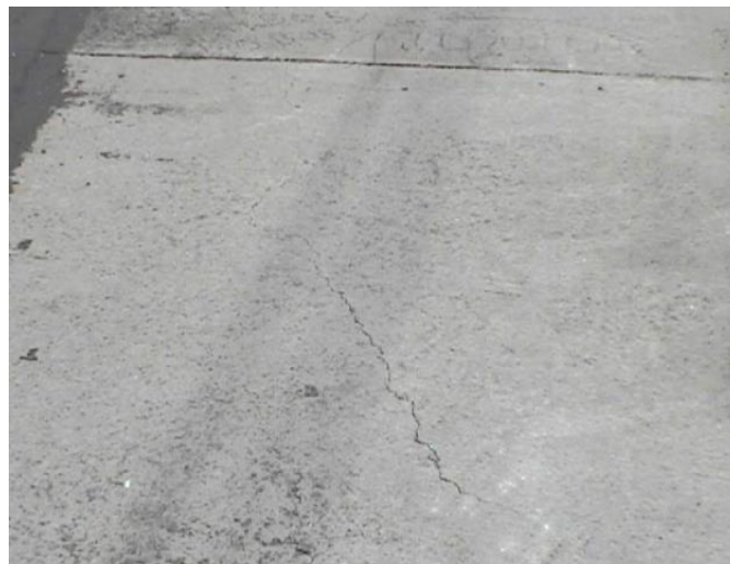
Figura 16: Fissuras superficiais. Fonte: DNIT 061/2004.
