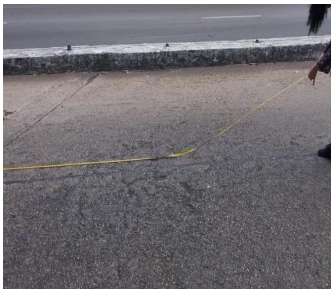
Figura 13: Desgaste superficial. Fonte: Autores, (2018).
