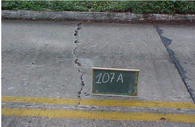
Figura 8: Fissuras transversais. Fonte: DNIT 061/2004.
