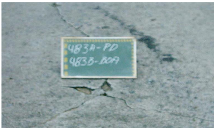
Figura 22: Buracos. Fonte: DNIT 061/2004.
