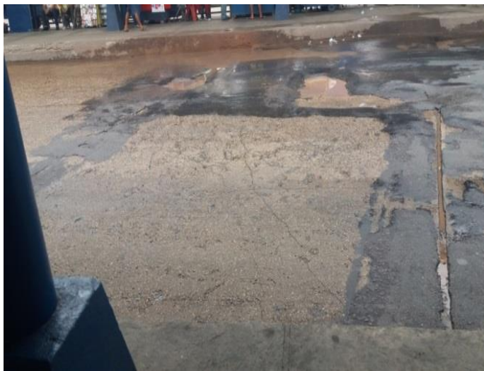
Figura 14: Bombeamento. Fonte: Autores, (2018).
