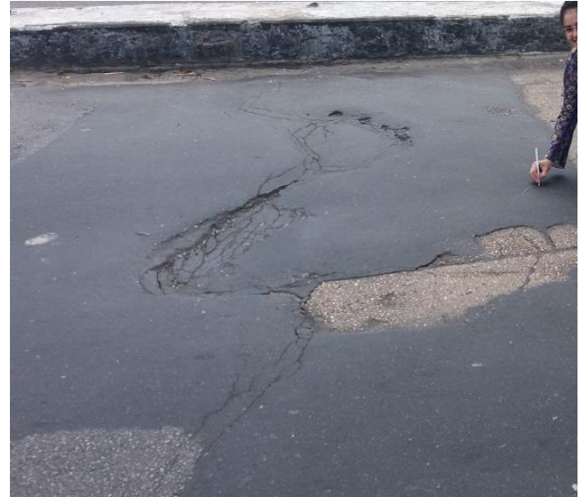
Figura 11: Grandes reparos. Fonte: Própria autoria, 2018.
