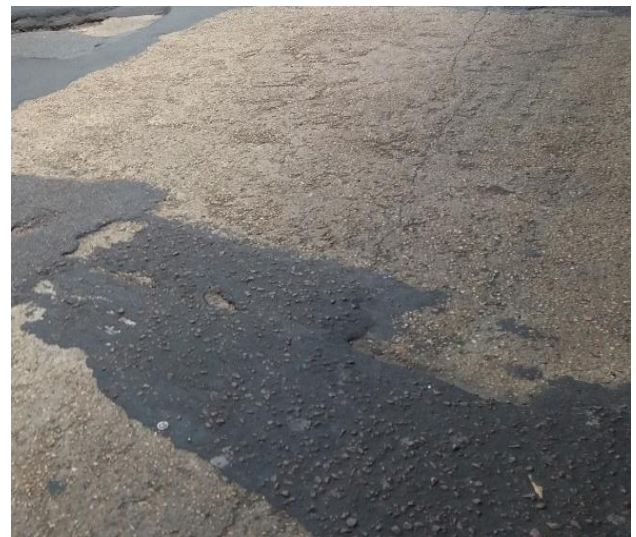
Figura 12: Pequenos reparos. Fonte: Autores, (2018).
