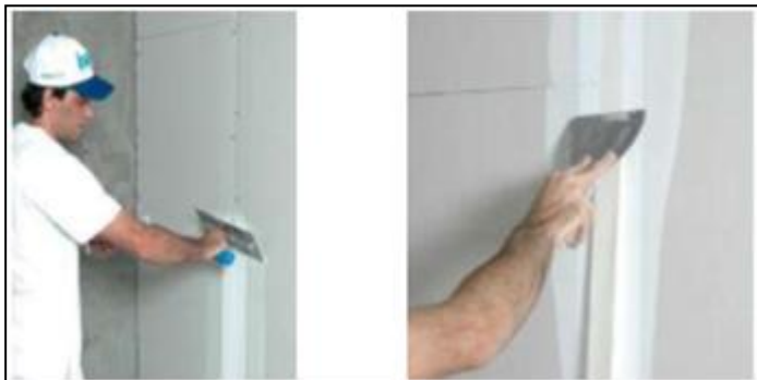
Figura 4: Rejunte de Drywall com massa e fita de rejunte
