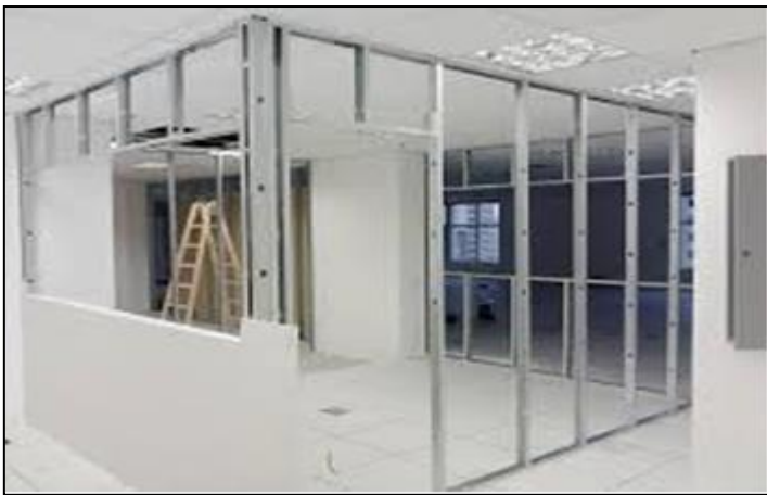
Figura 3: Instalação Drywall.
