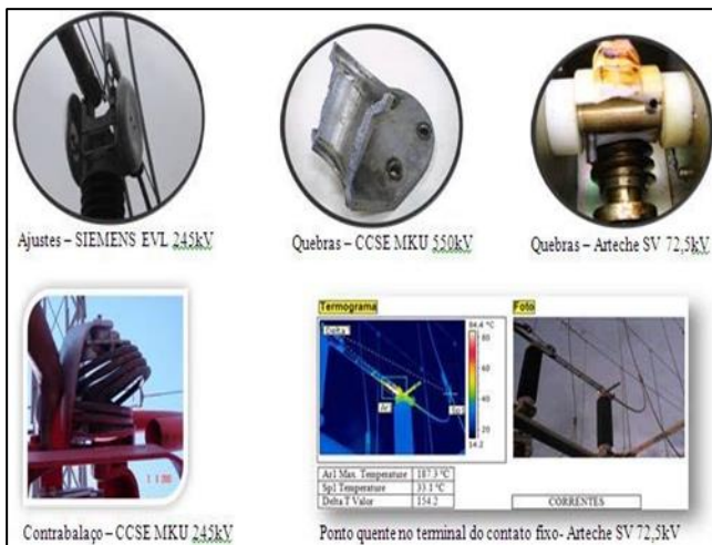
Figura 4: Problemas em chaves seccionadoras Fonte: Autores, (2018).
