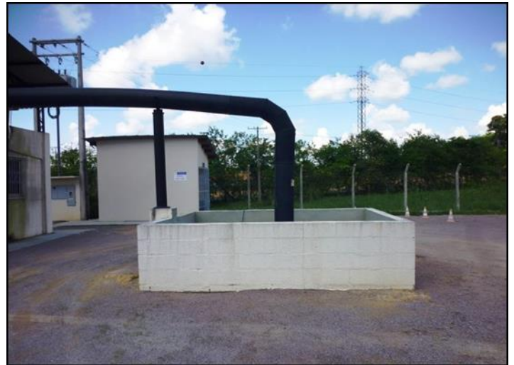
Figura 6: Caixa de remoção de condensado. Fonte: Autor, (2018).
