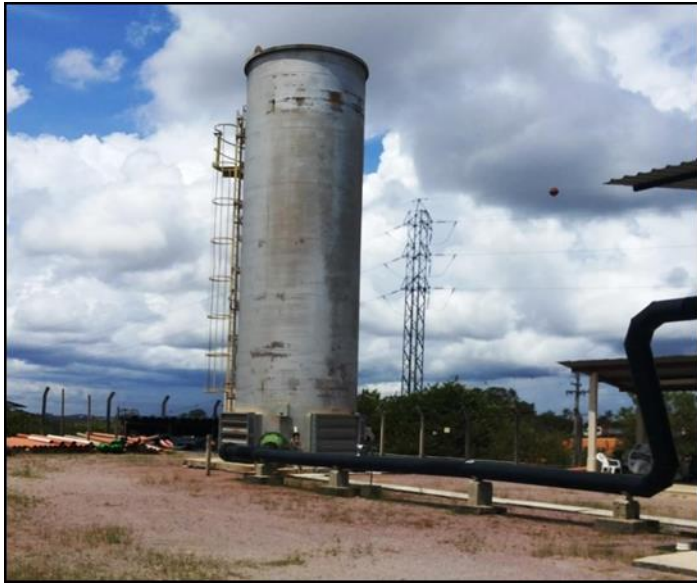
Figura 10: Flare enclausurado. Fonte: Autor, (2018).
