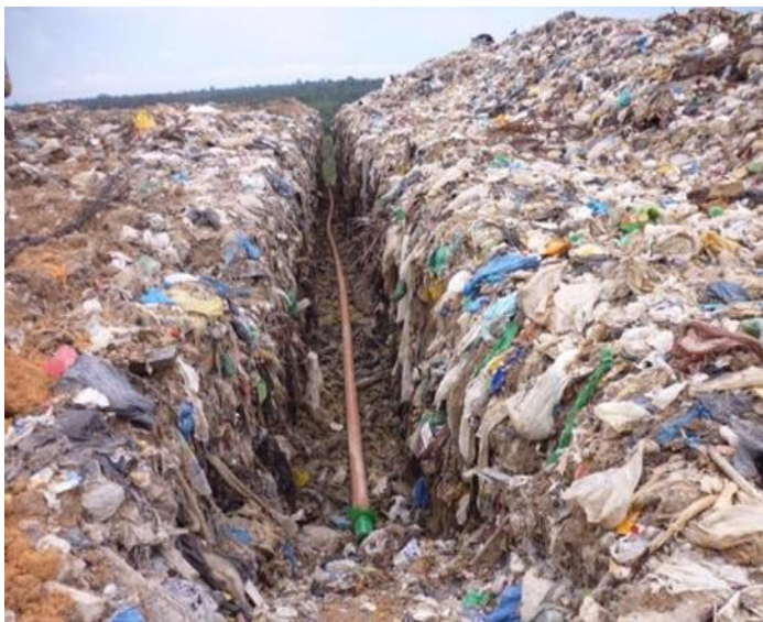
Figura 4: Instalação de um Dreno horizontal. Fonte: Autor, (2018).
