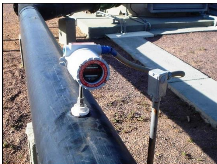
Figura 9: Medidor de Vazão de LFG.
