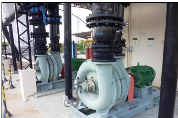
Figura 7: Conjunto de Sopradores.
