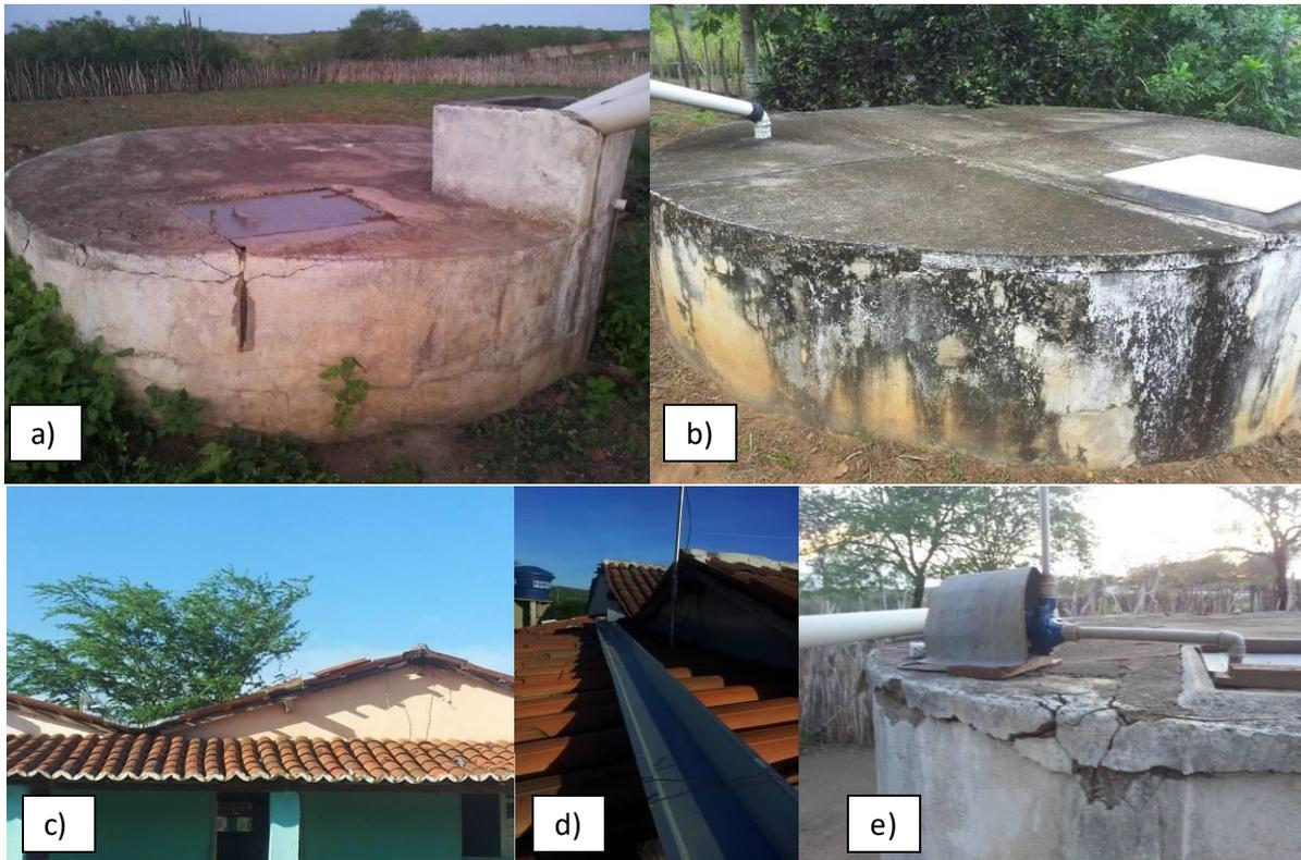
Figura 1: a) Estado geral da cisterna do Sistema 15 (Ruim), em Cabaceiras – PB; b) Estado da pintura da cisterna do Sistema 27 (Ruim), em São Sebastião de Lagoa de Roça – PB; c) Estado geral do telhado do Sistema 12 (Ótimo), em Cabaceiras – PB; d) Calha do Sistema 12 (Bom), em Cabaceiras – PB; e) Cisterna na qual se utiliza bomba elétrica, em Cabaceiras – PB.
