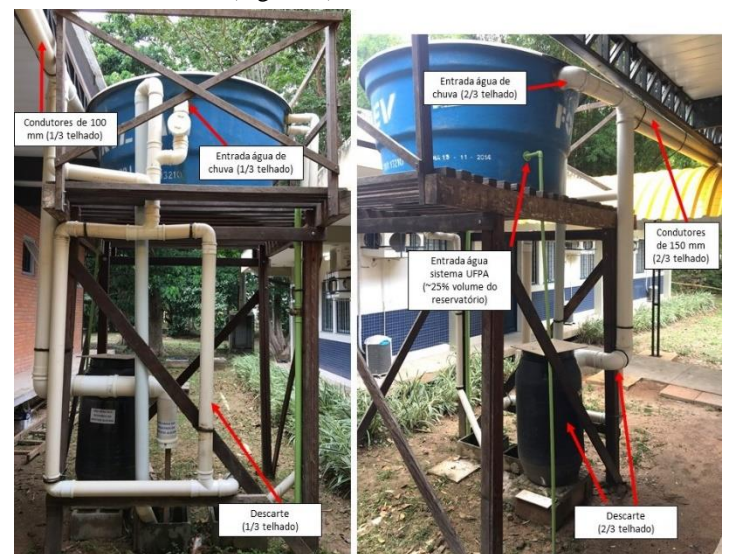
Figura 2: Sistema de aproveitamento de água de chuva do NUMA-UFPA.
