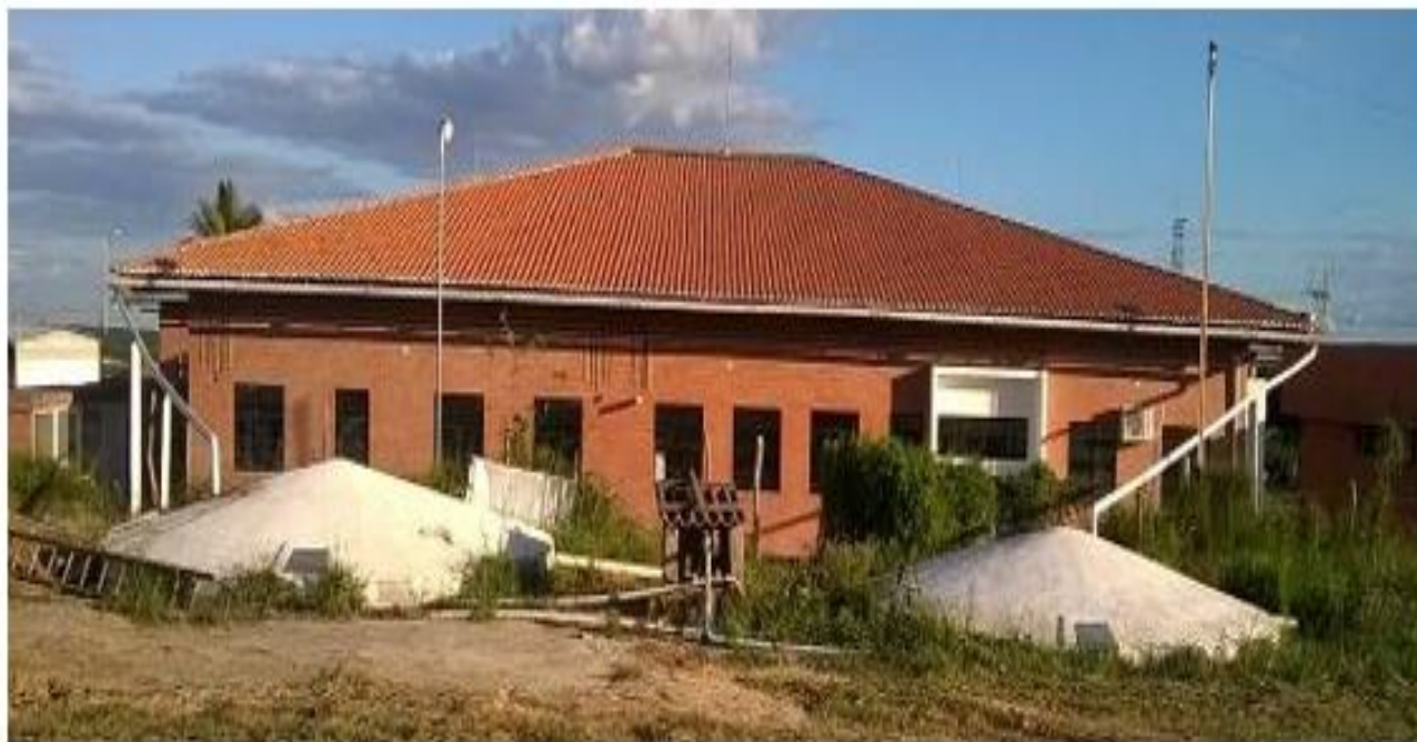
Figura 4: Vista do sistema de captação e armazenamento de água da chuva montado. Fonte: Autores, (2016).
