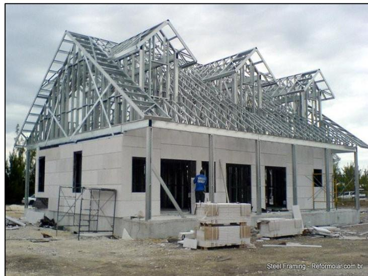
Figura 1: Modelo de Residência em LSF.
