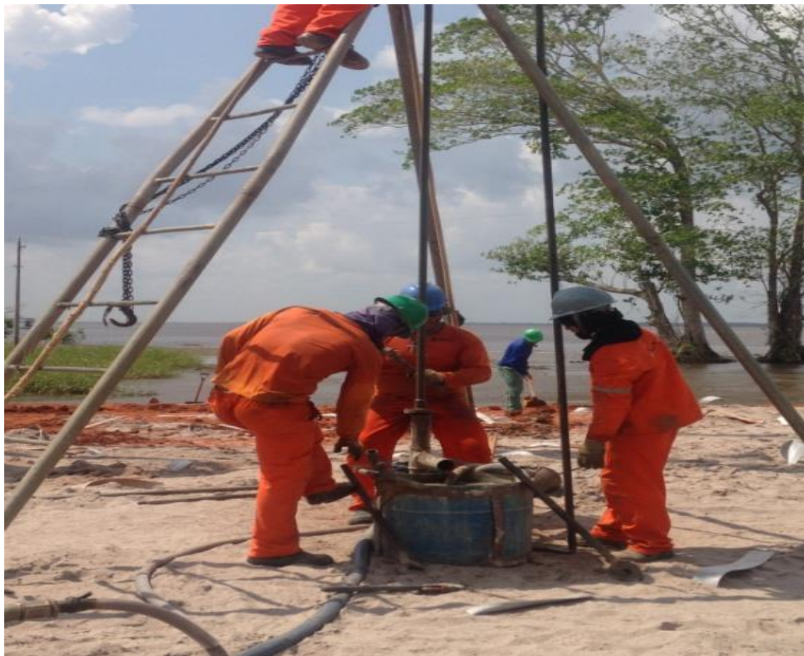
Figura 14: Sondagem SPT. Fonte: Autores, (2015).
