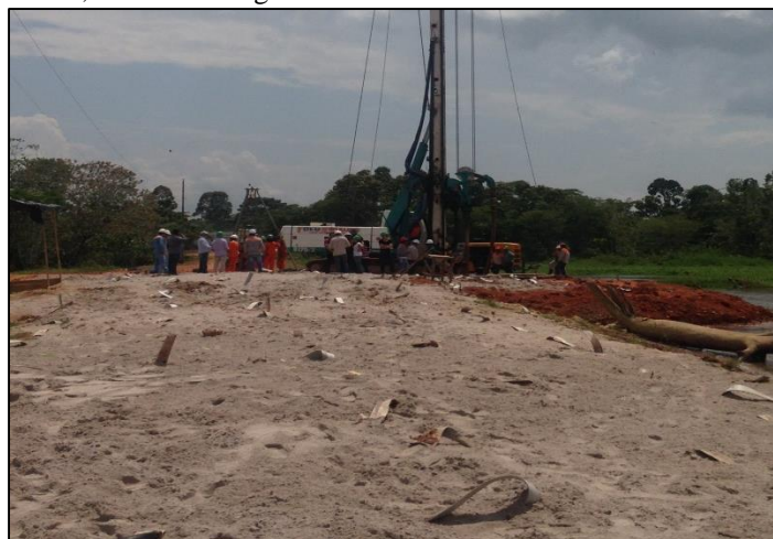
Figura 10: Instalação de Geodrenos. Fonte: Autores, (2015).
