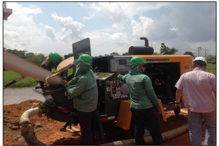
Figura 5. Bombeamento do composto grout. Fonte: Autores, (2015)
