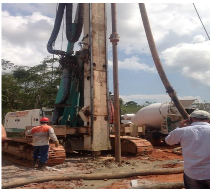
Figura 11: Injeção da argamassa. Fonte: Autores, (2015).
