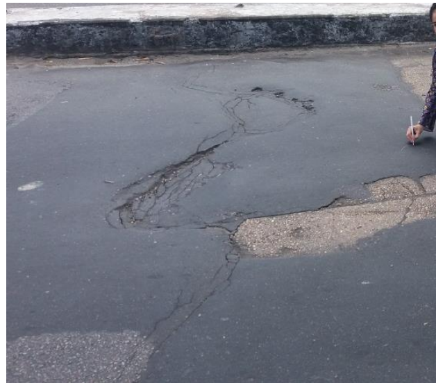
Figura 11: Grandes reparos. Fonte: Própria autoria, 2018.
