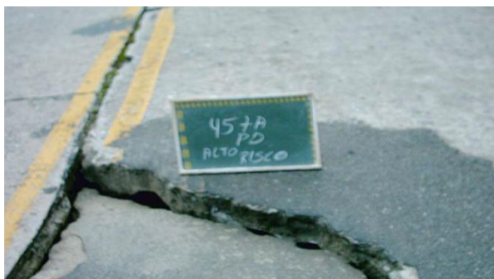
Figura 18: Quebra de canto. Fonte: DNIT 061/2004.
