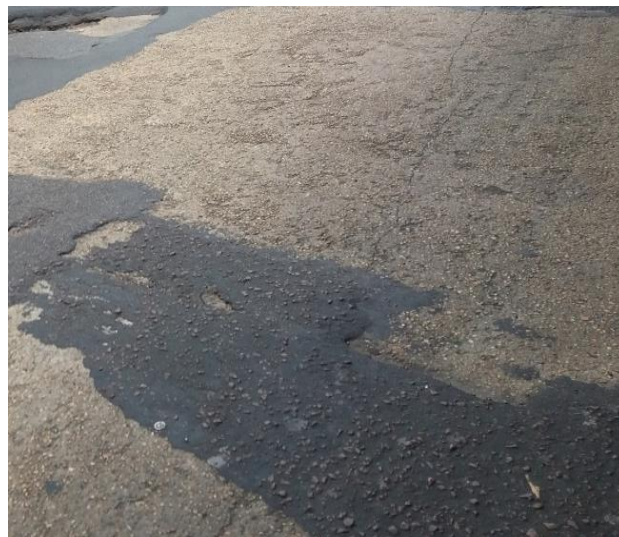
Figura 12: Pequenos reparos. Fonte: Autores, (2018).
