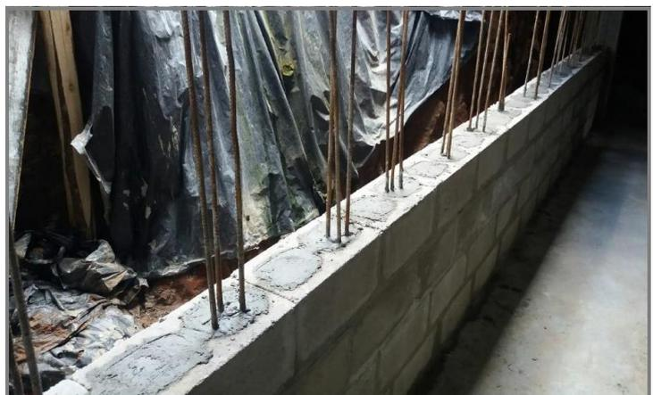
Figura 3: Armadura no bloco de concreto grauteado.
