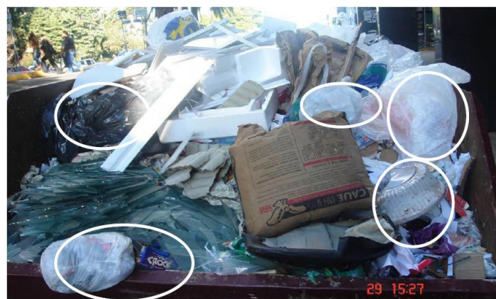
Figura 1: Resíduos orgânicos na caçamba de resíduos de construção civil.
