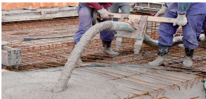
Figura 13: Concretagem das lajes nervradas.
