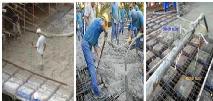
Figura 14: Concretagem das lajes nervuradas
