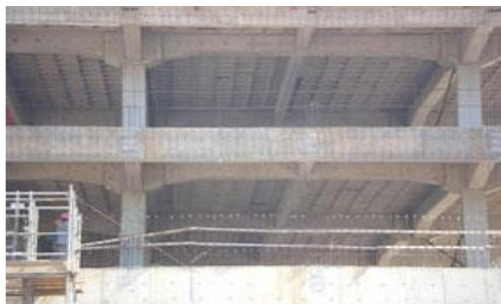
Figura 5: Lajes nervurada.
