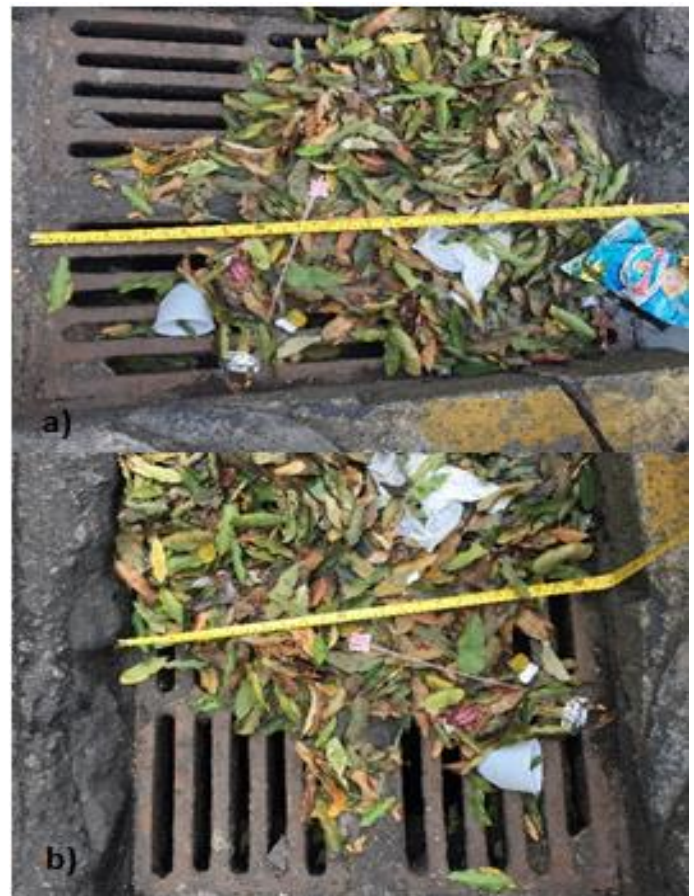
Figura 5: a) e b) Boca de lobo IV, esquina Avenida Getúlio Vargas/Rua 24 de Maio. Fonte: Autores, (2018).
