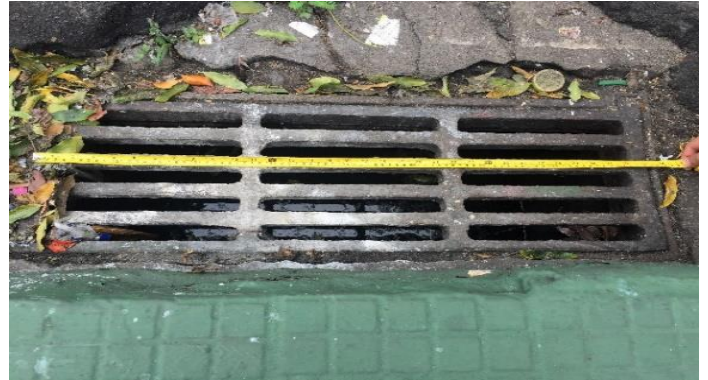
Figura 6: Boca de lobo I. Fonte: Autores, (2018).
