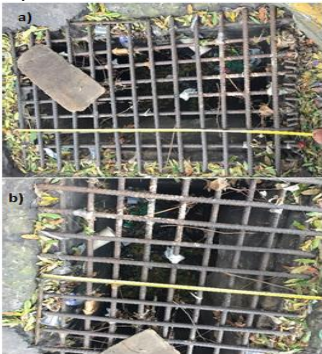
Figura 4: a) e b) Boca de lobo III, esquina Avenida Getúlio Vargas/Rua Huascar Figueiredo. Fonte: Autores, (2018).
