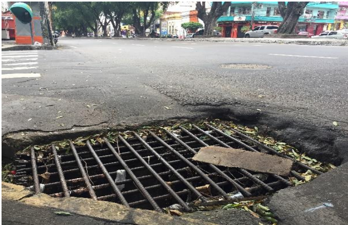
Figura 8: Boca de lobo III. Fonte: Autores, (2018).
