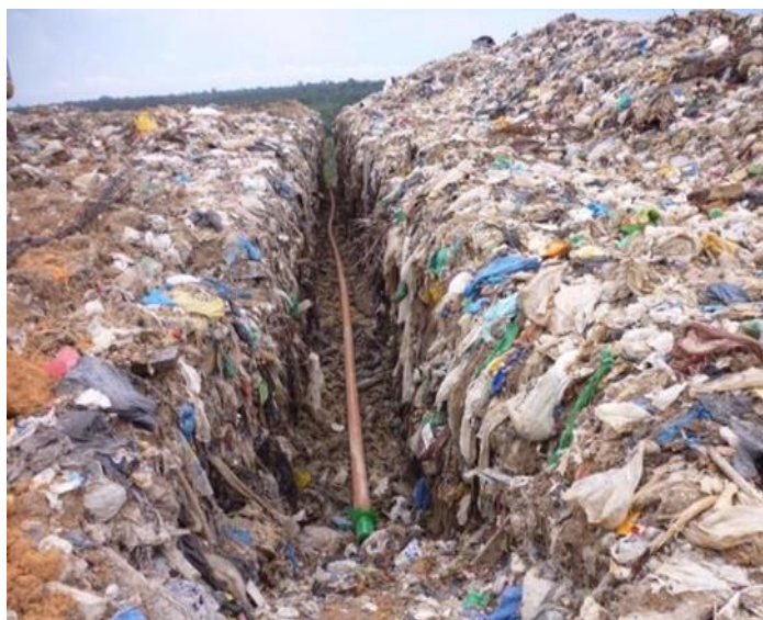
Figura 4: Instalação de um Dreno horizontal. Fonte: Autor, (2018).
