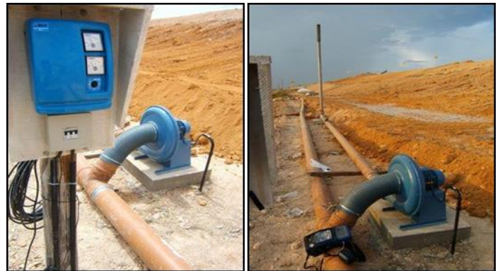
Figura 1: sistema piloto de captação de biogás. Fonte: Acervo do Aterro de Manaus. Fonte: Autores, (2018).
