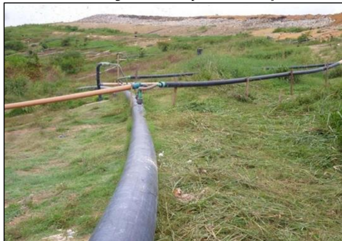
Figura 5: Tubulação de coleta em PEAD 315 mm. Fonte: Autor, (2018).
