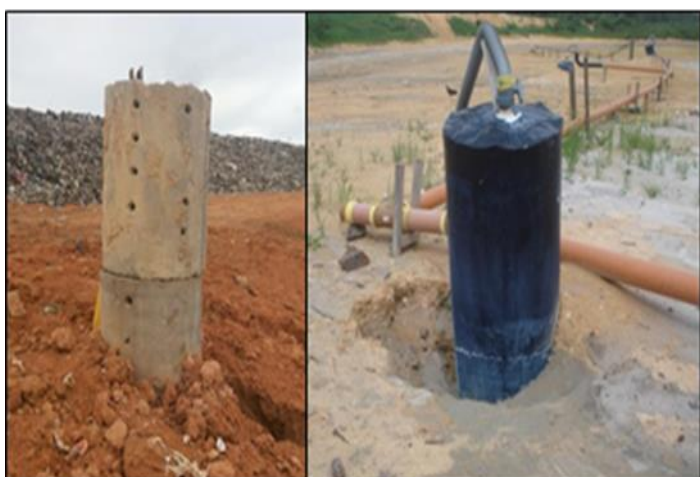
Figura 3: Dreno vertical antes e após ser conectado ao sistema de coleta. Fonte: Autor, (2018).
