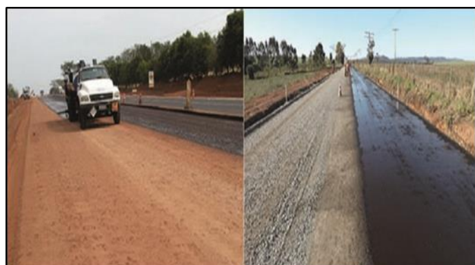
Figura 5: Aplicação da emulsão asfáltica de imprimação (EAI). Lado esquerdo/solo-brita cimento, lado direito/ brita graduada simples.
