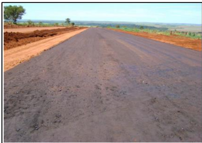
Figura 3: Base imprimada com CM- Imprimação, após preparação de subleito e sub-base.
