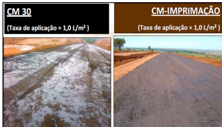
Figura 4: CM 30 e CM-Imprimação após tratamento de subleito e sub-base.
