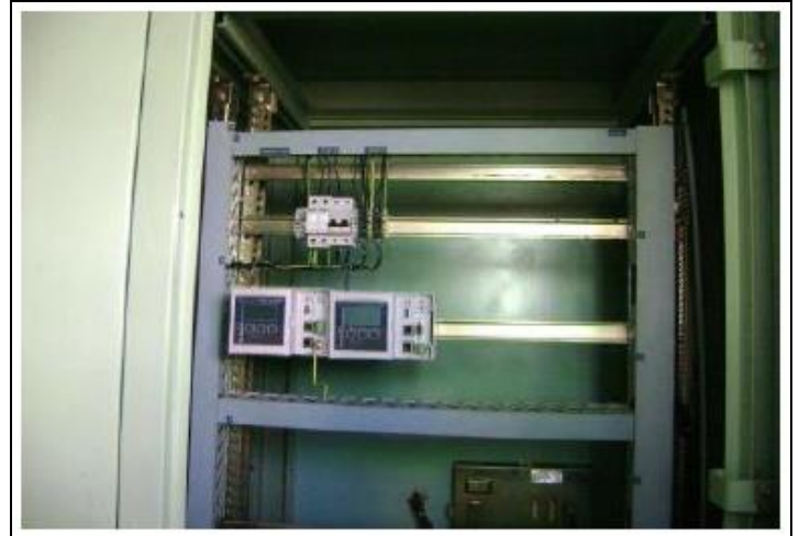
Figura 3: TankScanner NXA820 instalados en el campo. Fuente: Los Autores, (2015).
