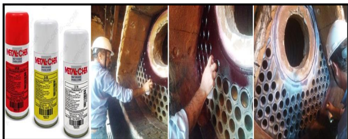
Figura 10: Aplicação de líquido penetrante (END). Fonte: Autores, (2019).
