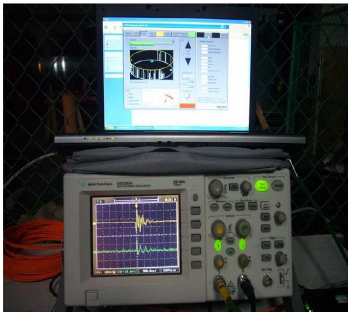
Figura 8: Detección eléctrica y acústica de DP. Fuente: Autores, (2017).
