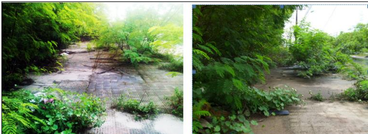
Figura 6: O estado de degradação e falta de saneamento básico na área do Calçadão.
