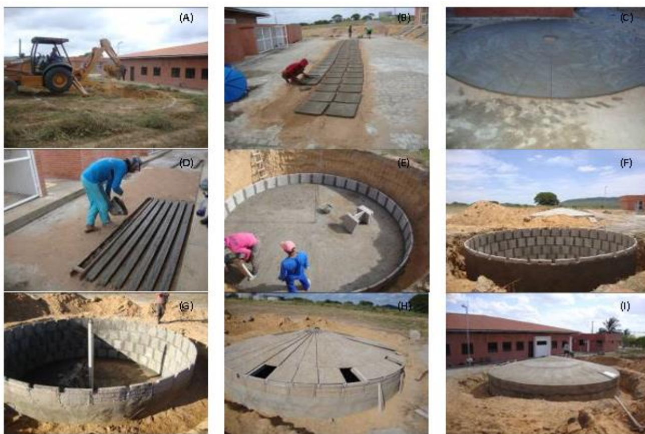
Figura 2: Construção das cisternas de produção. A – Escavação com círculo demarcado; B – Confecção das placas da parede; C - Confecção das placas da cobertura; D – Construção dos caibros; E – Início da construção da parede e visão da base da cisterna n segunda concretagem; F – Visão da parede construída; G - coluna central moldada em tubo PVC; H – Posicionamento das placas da cobertura; I – Cisterna finalizada.
