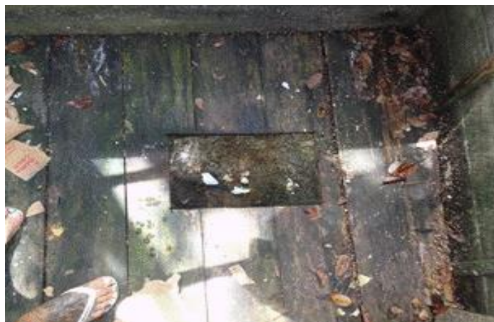
Figura 5: de Banheiro sem Tratamento – PAE Pacajá I. Fonte: IATAM, (2015).
