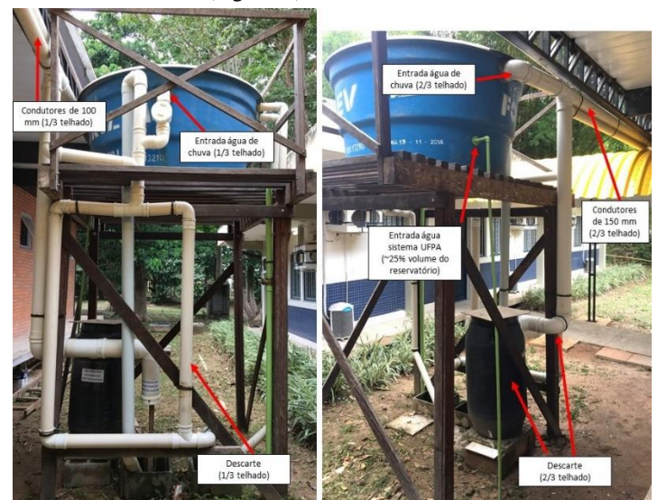
Figura 2: Sistema de aproveitamento de água de chuva do NUMA-UFPA.
