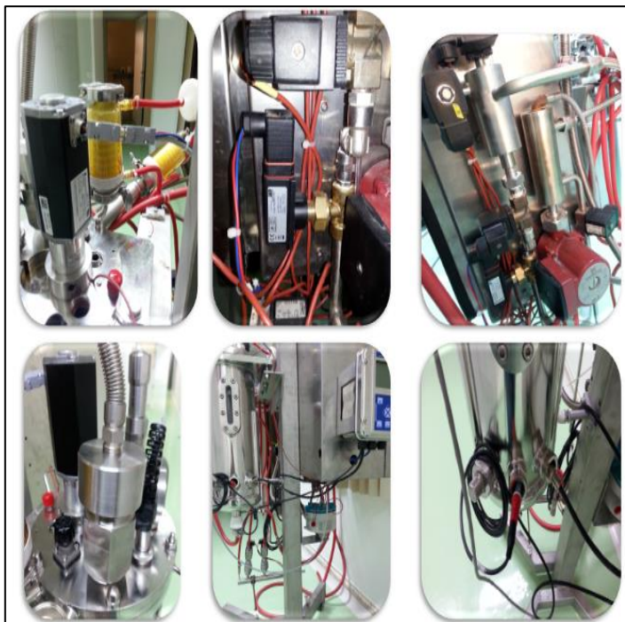
Figura 6: Montaje de sensores/transmisores y actuadores. Fuente: autores, 2017.
