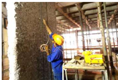
Figura 8: Limpeza dos furos. Fonte: Autores, (2019).
