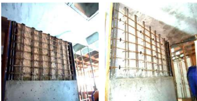
Figura 9: Preparo das formas para concretagem. Fonte: Autores, (2019).
