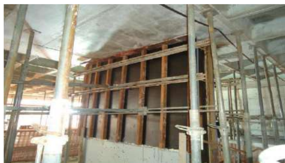
Figura 10: Forma para concretagem. Fonte: Autores, (2019).
