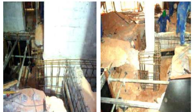
Figura 6: Marcação e execução dos furos, limpeza e fixação das ferragens do arranque. Fonte: Autores, (2019).
