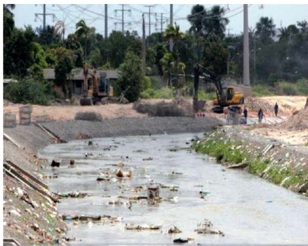
Figura 5: Obras de Engenharia do processo de revitalização do Mindu.
