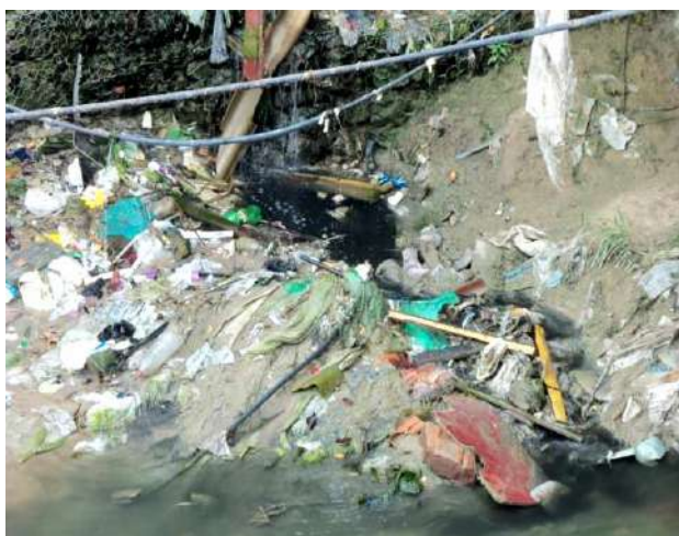
Figura 6: Lixo e sedimentos acumulados a baixo da ponte na rua da Feira do Mutirão (rua Itaeté).
