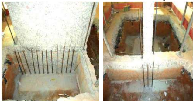
Figura 7: Lançamento das esperas do segundo subsolo. Fonte: Autores, (2019).
