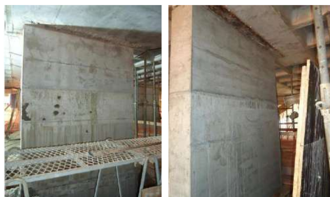
Figura 11: Reforço dos Pilares totalmente finalizados. Fonte: Autores, (2019).
