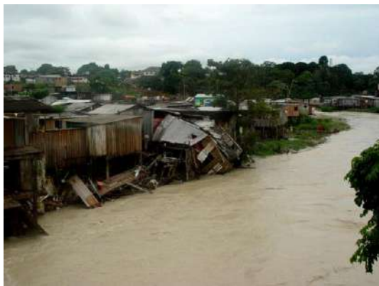
Figura 15: Desabamento após chuva intensa. Fonte: Autores, (2017).
