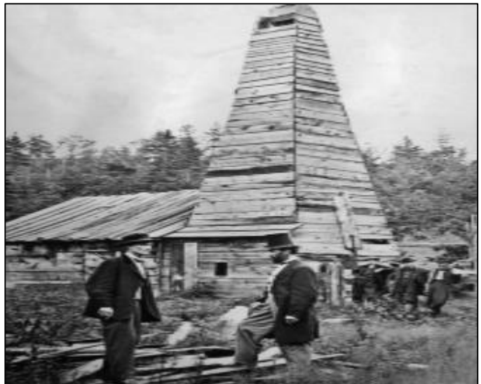
Figura 1: Primeiro poço de petróleo perfurado por Drake. Fonte: Lubrificantes & Lubrificação Industrial, (2006).
