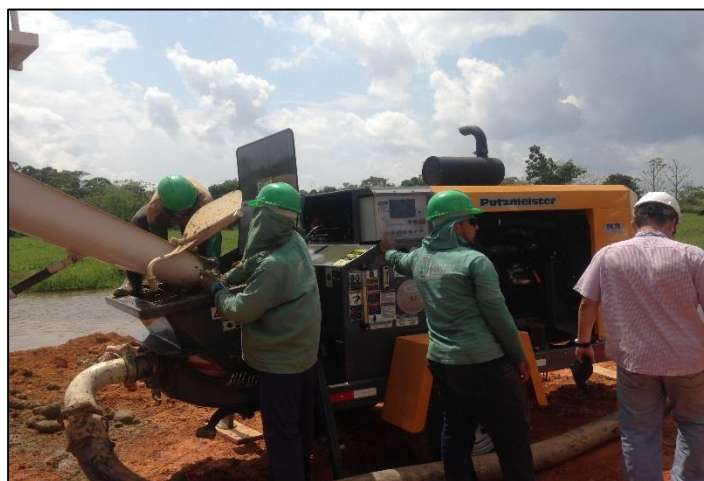
Figura 5. Bombeamento do composto grout. Fonte: Autores, (2015)
