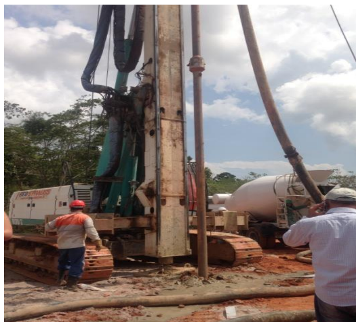
Figura 11: Injeção da argamassa. Fonte: Autores, (2015).
